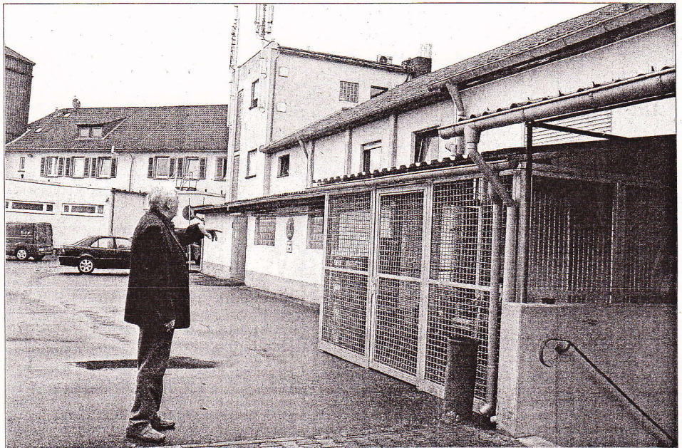
Im Feuerwehrhof zeigt der TSV-Vorsitzende Ulrich Plotzitzka den eingeschossigen Anbau, der abgerissen und zweigeschossig neu aufgebaut werden soll. Fotos (2): Diel
